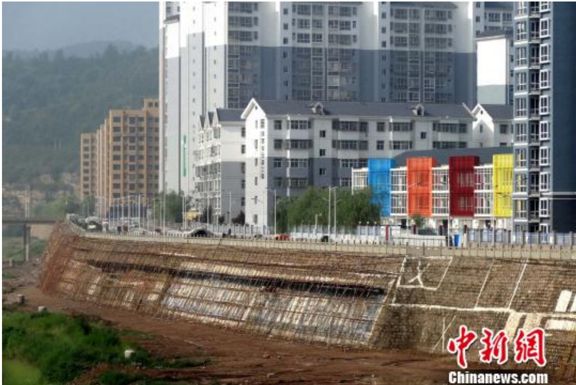
河堤正在施工恢复。 高庆国
